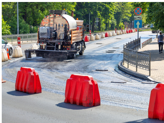
Påføring af tack coat
