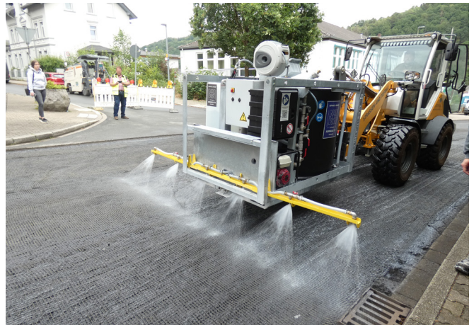
Sprøjtning med hydratkalk
