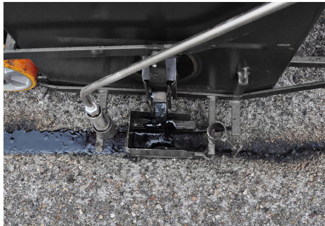
Udfyldning af revner med varm bitumen
