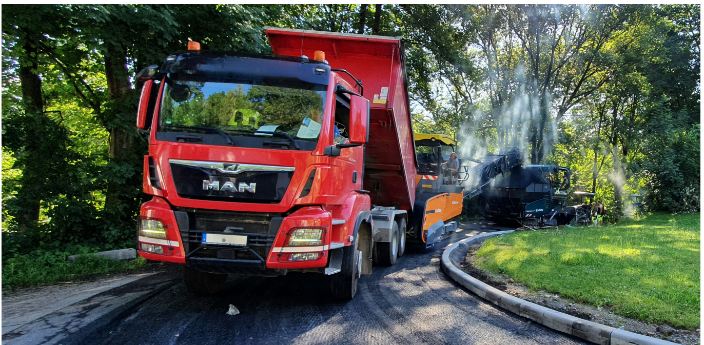
Asfaltudlæggere og transportkøretøjer skal køre forsigtigt
