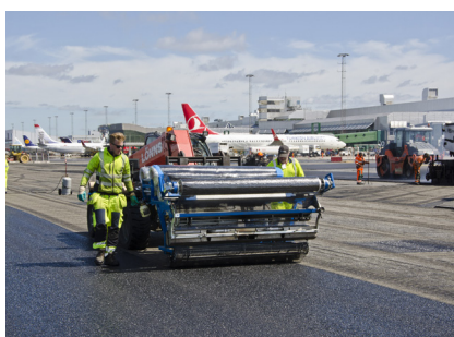
2 Emulsionen udlagt og armering installeres.
