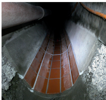
1 Kloak og ledningsrenovering
