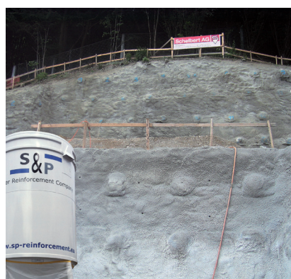
5 Anlæg (stabilisering af skrænter byggegruber)
