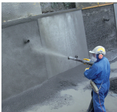
2 Kanal- og tankvægge
