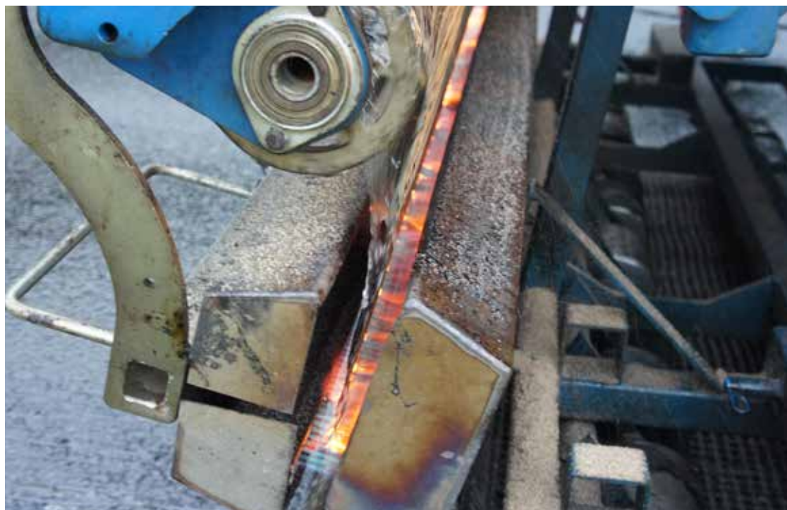
Opvarmning af bitumen på S&P asfaltarmeringsnet ved udlægning med S&P asfaltarmeringsudlægger
