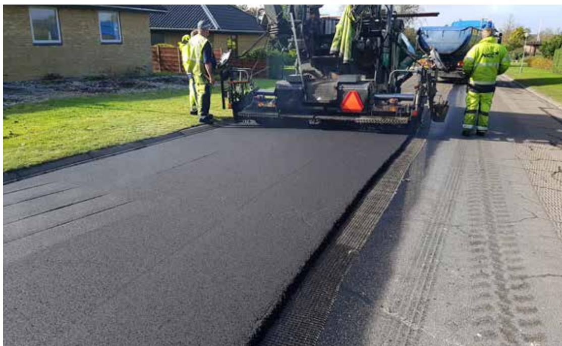
Udførelse af nyt slidlag armeret med S&P Carbophalt® G 200/200 i 2017
