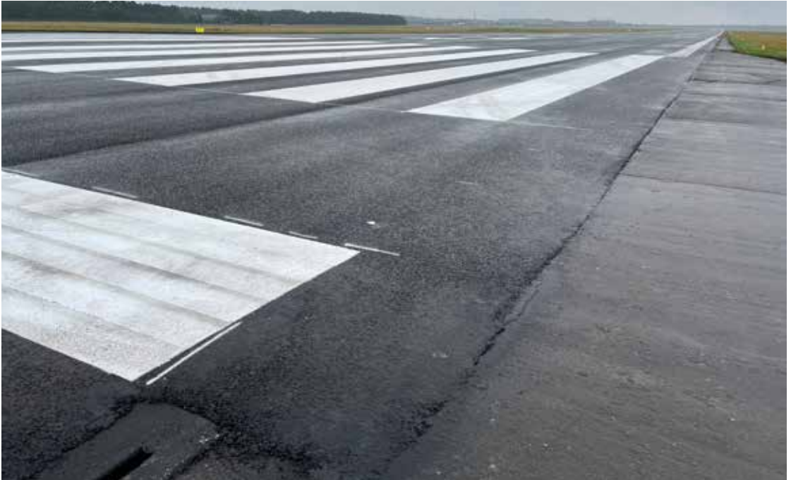
Færdig udlagt asfalt i 2021
