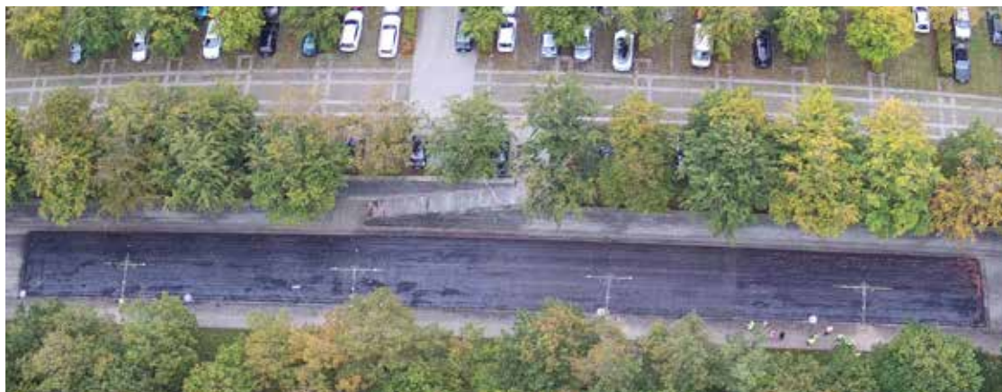
Smart Road på DTU under etableringsfasen. De fire krydsmarkeringer angiver placeringer af sensorer i de 4 sektioner
