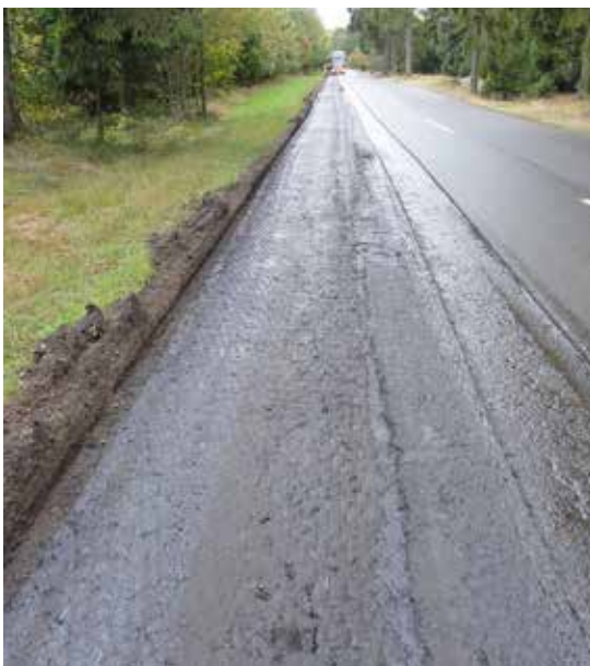
Billede af fræst overflade påført emulsion før udlægning af armering
