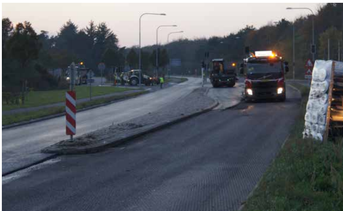
Asfaltentreprenørens udlægning af slidlaget på etape 1
