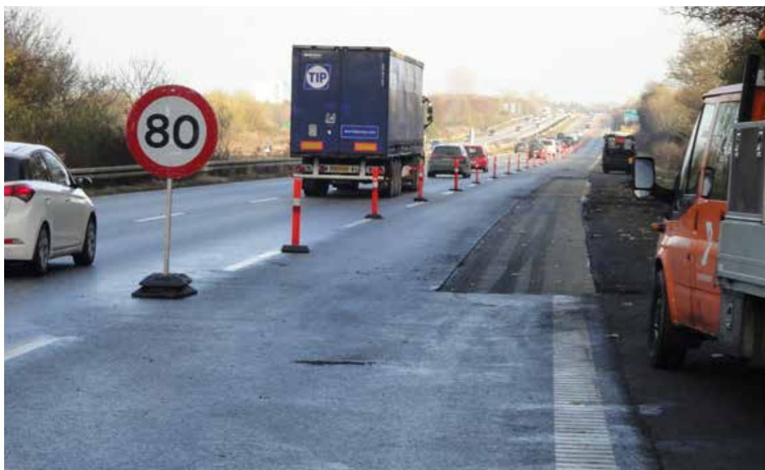
Udlagt S&P Carbophalt® G – klar til slidlag
