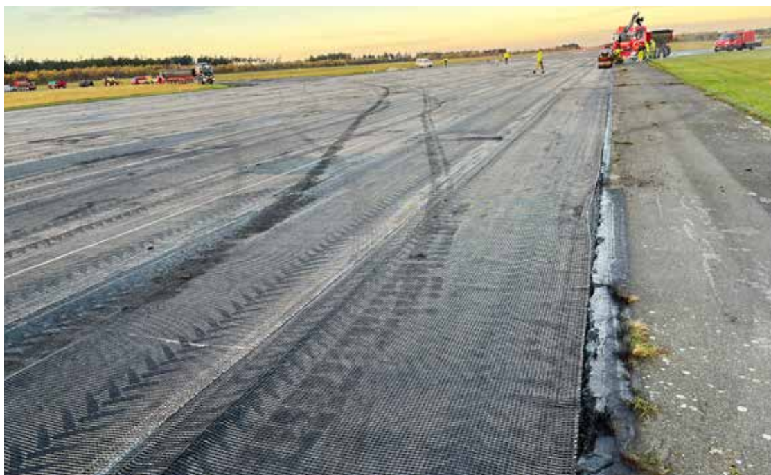
S&P Carbophalt G® 200/200 asfaltarmering udlagt på ABB lag i den vestlige ende af landingsbanen
