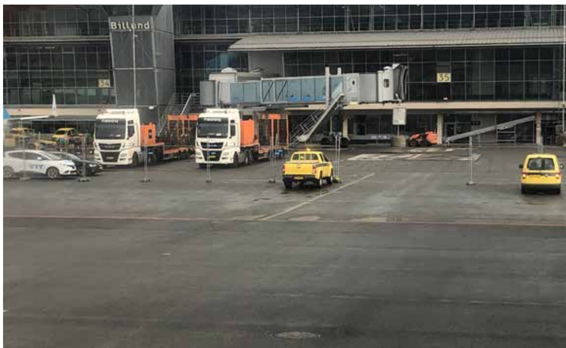
Reparationer af standpladser Billund lufthavn 2019
