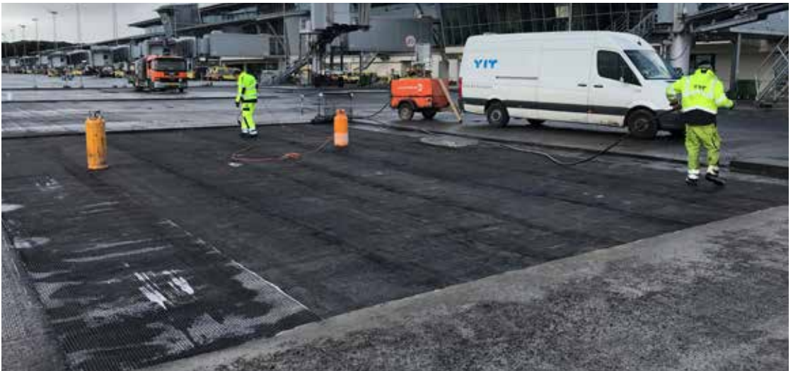
Installation af S&P Carbophalt® G 200/200 på ABB lag
