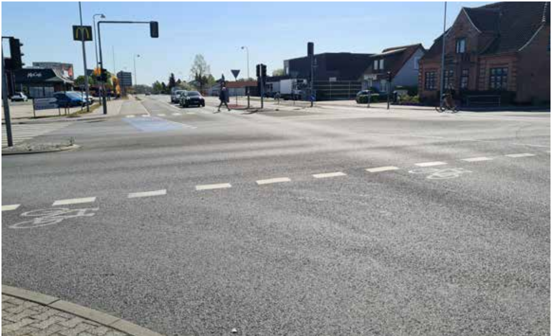
God tilstand uden synlige bæreevneproblemer i armerede områder, konstateret under observation i 2022
