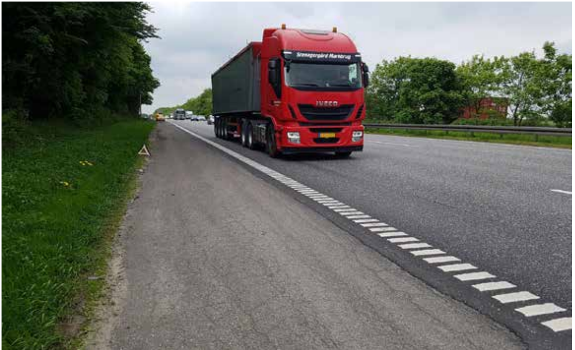
Strækning med S&P Carbophalt® G på HBB-lag samt mellem bærelag og slidlag i 2022
