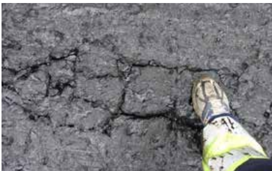
Billede af fræst overflade påført emulsion før udlægning af armering
