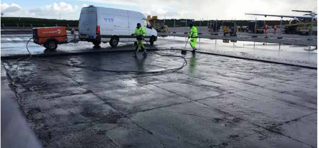
Klargøring af overflade ABB lag
