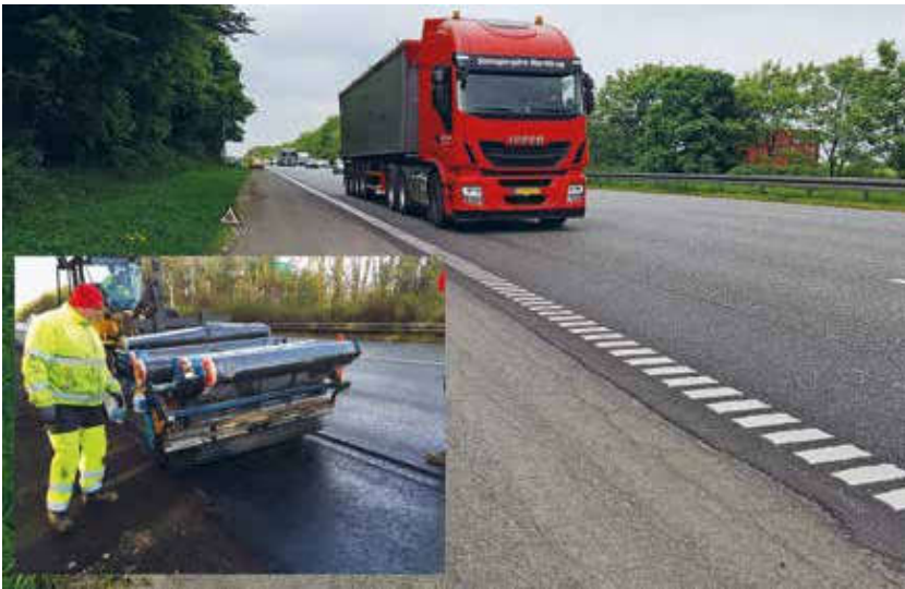
Figur 4: M40 – udlægning af armering af samlinger under slidlag.
