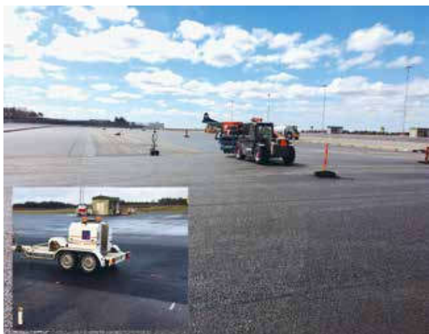
Figur 1: Gøteborg Lufthavn, faldlodsmåling og kulfiberarmering af parkeringsareal.
