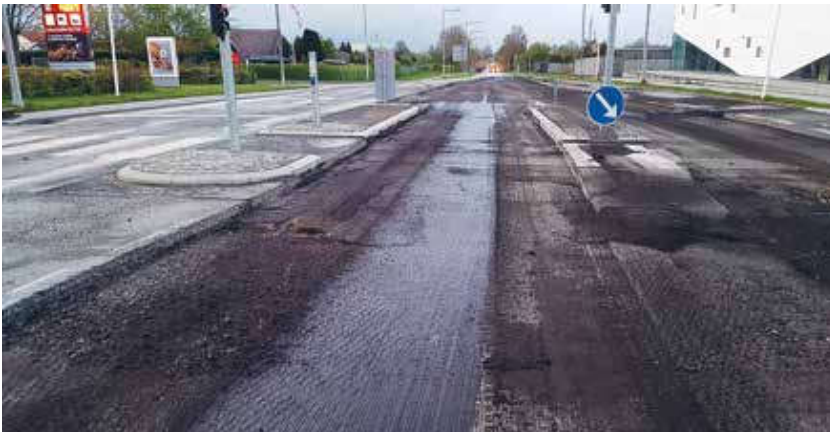
Figur 5: Vejlevej – Vestre Ringvej, bærelag efter fræsning.
